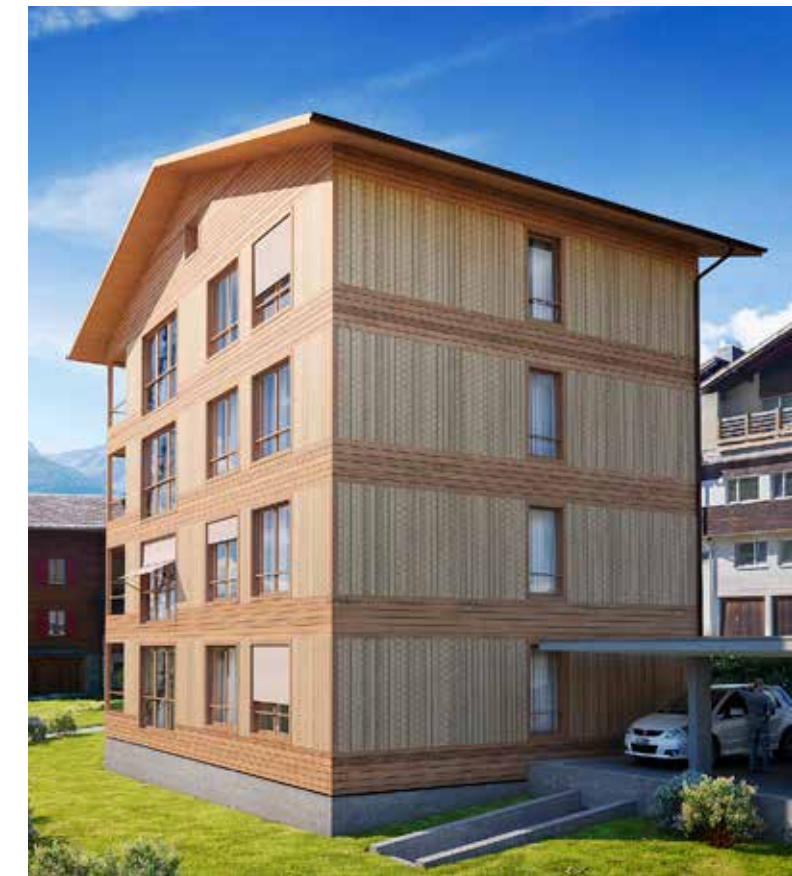
Maison en bois de lune en cours de construction à Fiesch.
